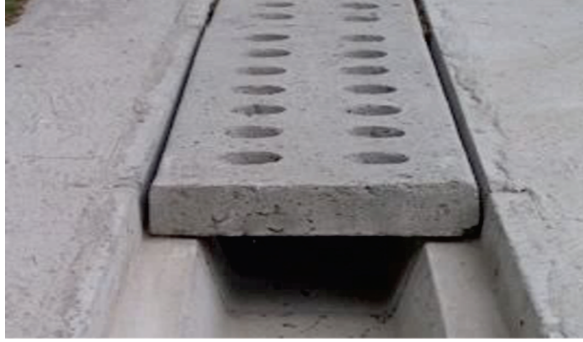
Figura 44. Sistemas de drenajes con placas prefabricadas
