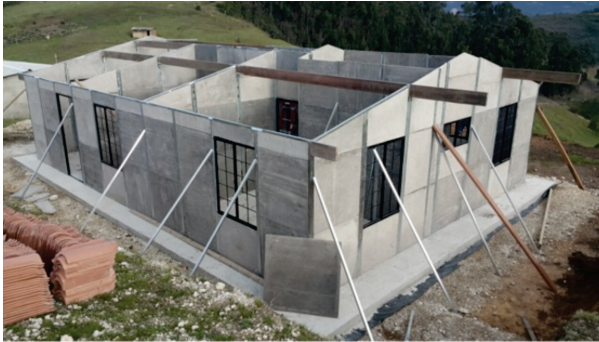
Figura 41. Vivienda modular con placas prefabricadas
