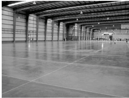
Figura 50. Pisos industriales reforzados con fibras
