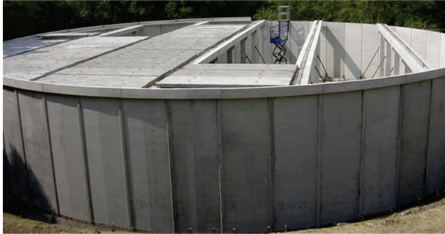
Figura 42. Tanques construidos con placas prefabricadas
