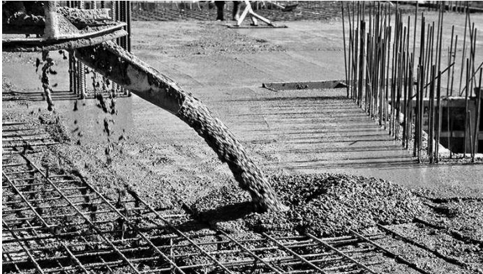
Figura 1.1 Vaciado del concreto..
