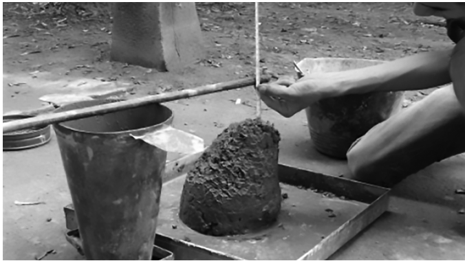
Figura 4.1 Medición de asentamiento del concreto.
